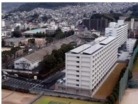
三菱重工独身寮に導入された太陽電池パネル
