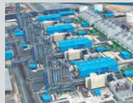
ラヨーン県 ガス複合火力発電所 (タイ)
