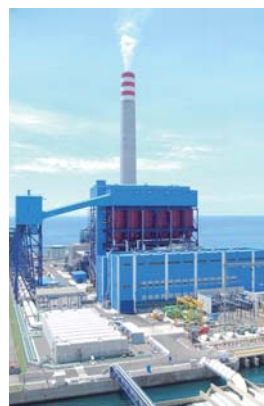
石炭火力発電所
