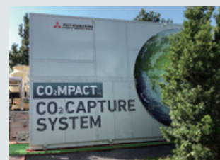
横浜市資源循環局鶴見工場に設置した 小型CO 2 回収装置「CO 2 MPACT(コンパクト)」
